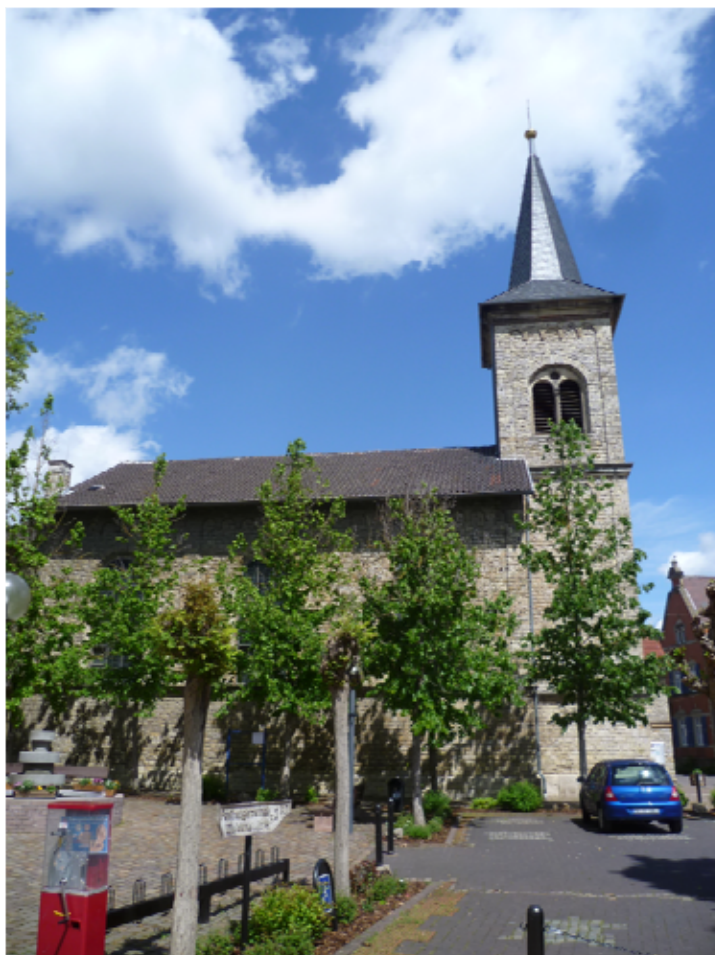
St. Viktor, unsere katholische Kirche, ist aus Richtung Süden ein markantes Wahrzeichen von Guntersblum. Für das dringend sanierungsbedürftige Dach braucht es Spenden.
